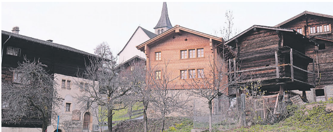
Neue Haut. Das alte Heidenhaus (Bildmitte) wurde an weiten Teilen der Fassade mit neuen Schindeln eingepackt.
